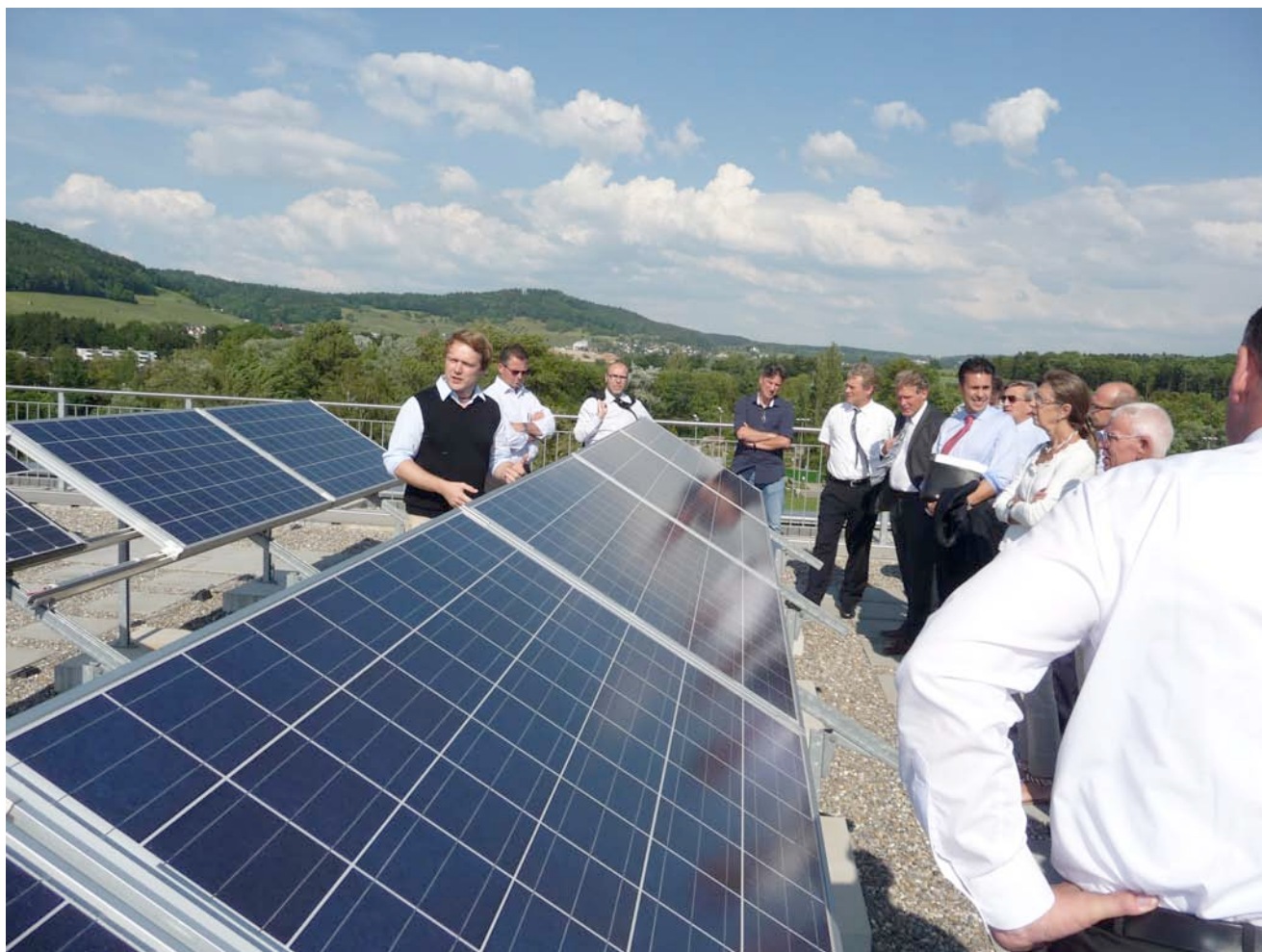
Die EKZ betreiben auf dem Dach ihres Werkhofes in Dietikon ein grosses Testfeld mit unterschiedlichen Photovoltaik-Komponenten.
